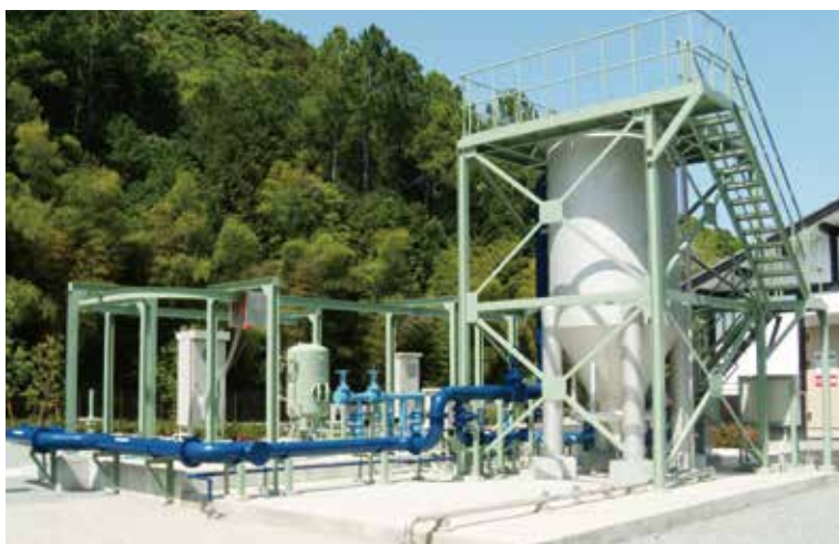
用水設備（砂ろ過＋紫外線消毒）
