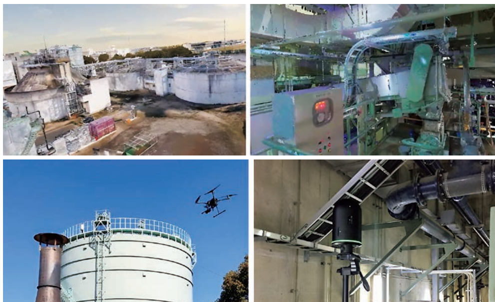
図-1 フォトグラメトリ（左）と点群データ（右）による 3D モデル化状況
