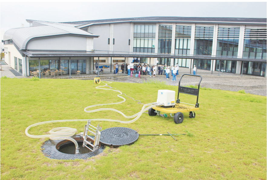
避難訓練では、敷地内に埋設されている耐震性貯水槽からの取水を実施
