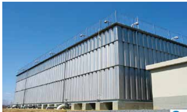
配水池 2,000m³(2槽式)
