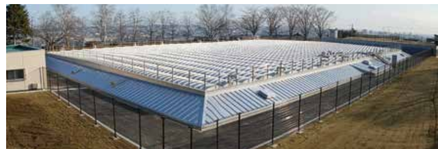
配水池 7,200m³(2槽式)
